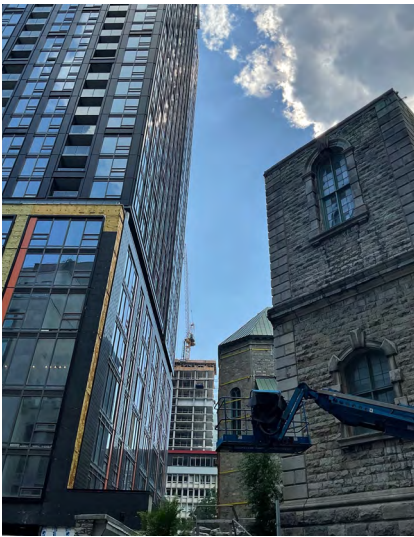
Le nouveau voisin du Gesù.
