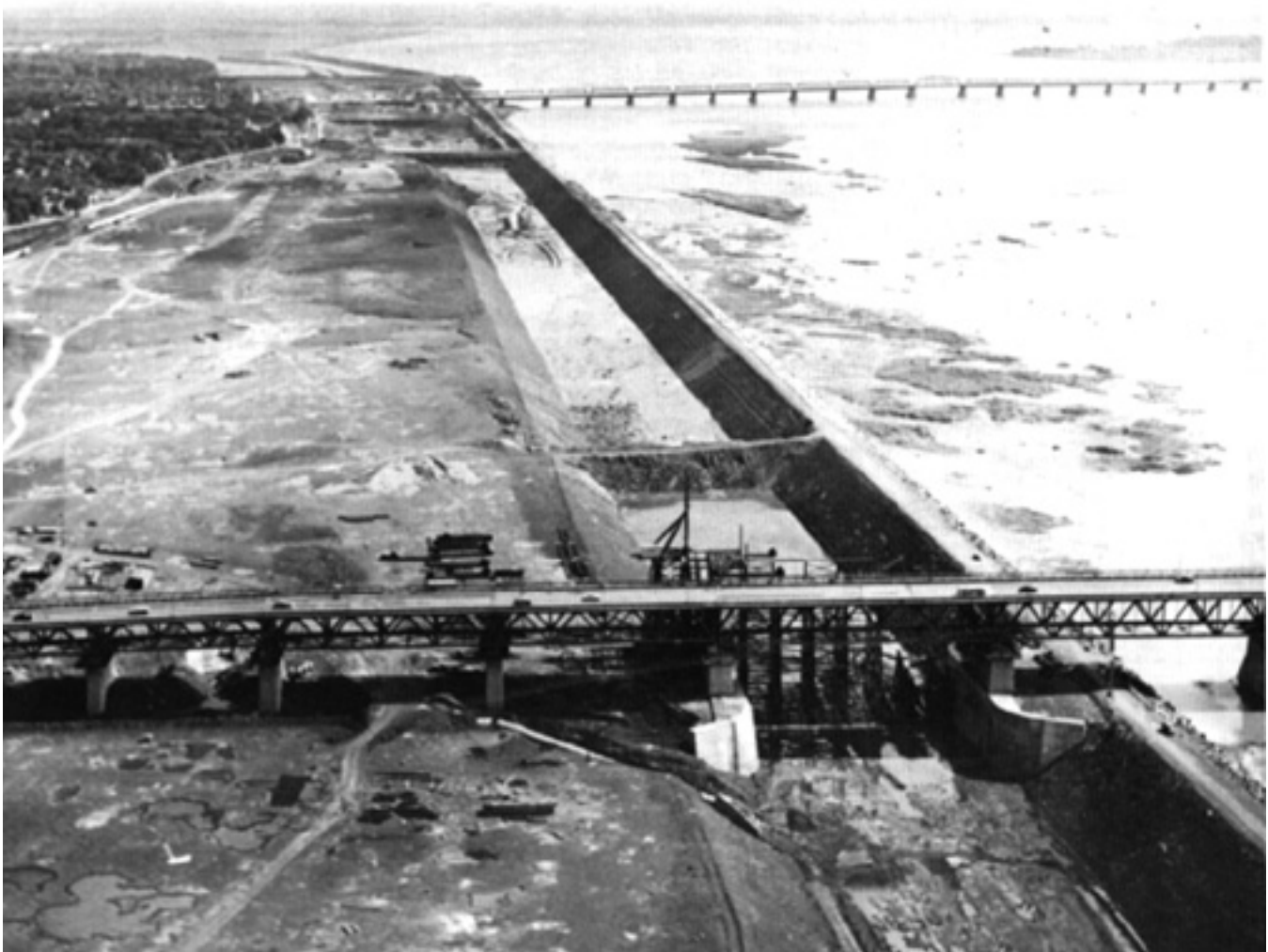
Fig.1. Canal du Saint-Laurent en 1958. On a installé les échafaudages pour surélever le pont Jacques-Cartier au-dessus de ce qui deviendra en 1959 la Voie maritime du Saint-Laurent. Au loin le pont Victoria.
